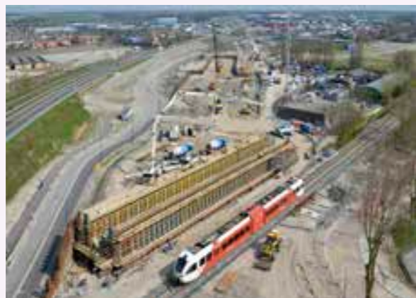
Figuur 9 Spoorviaduct in aanbouw naast spoor, Harlingen (Bron: projectorganisatie)
